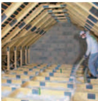
Soufflage d'isolant en combles.
